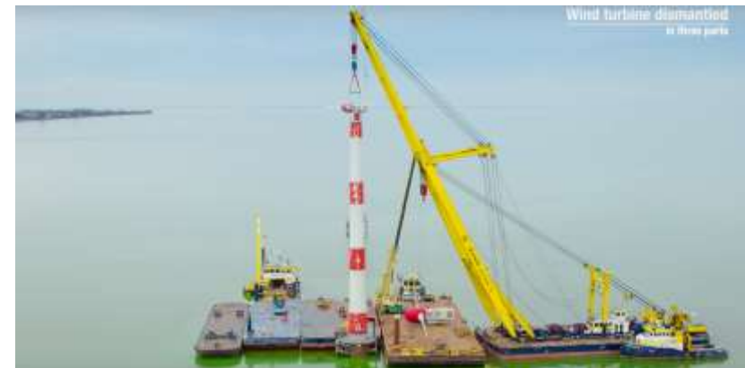
Usina eólica offshore, instalada em 1994, em Holanda , 4 turbinas de 500 kW. Foi descomissionado em 2016.
