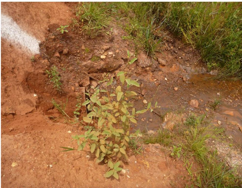
ITS05 (3): Processos erosivos no talude da via de acesso, a jusante.
