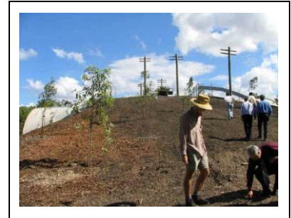
Figura 36. Implantação da vegetação na passagem superior. Ao fundo, postes com poleiros para aves (VEAGE & JONES 2007).
