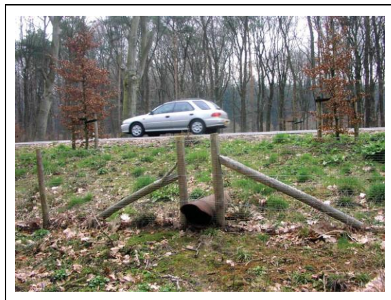
Figura 23. Túnel para pequenos mamíferos, com cerca direcionadora (CLEVENGER & HUIJSER 2011).
