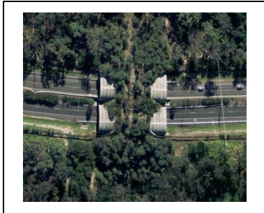
Figura 34. Vista aérea da passagem superior instalada na Campton Road, Brisbane, Austrália. Imagem: Google Earth, 15/06/2009.
