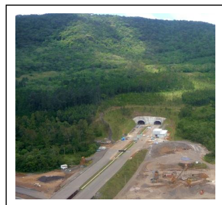
Figura 46. Emboque Norte do túnel sob o Morro Alto, BR 101/RS.
