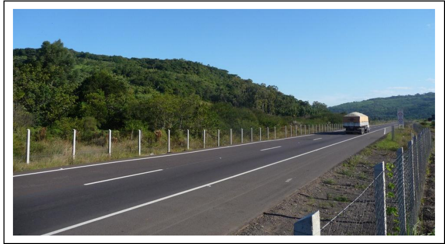
Figura 95. Cercas instaladas nos dois lados da pista. BR 101/RS.
