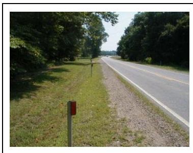
Figura 79. Refletores instalados em rodovia americana. Foto: www.strieter-lite.com
