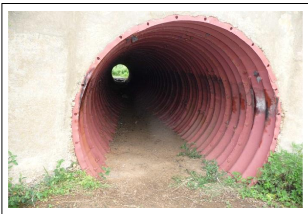
Figura 22. Passagem de fauna construída com bueiro tubular corrugado na BR 471/RS – Estação Ecológica do Taim.
