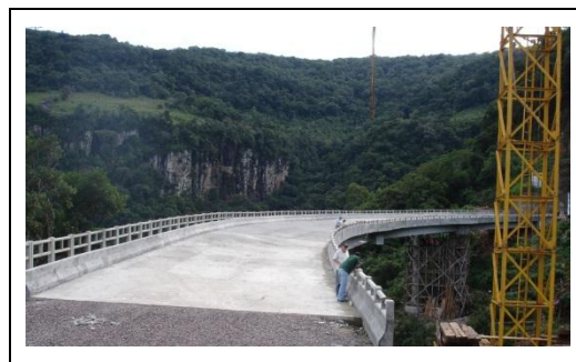
Figura 48. Viaduto na rodovia RS 486 - Rota do Sol, Rio Grande do Sul.
