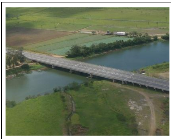
Figura 51. Detalhe da elevada no trecho sobre o canal do rio Maquiné, BR 101/RS.
