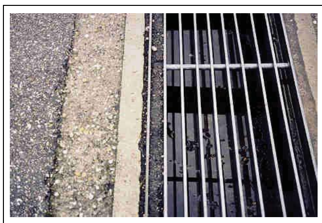
Figura 29. Duto subsuperficial para anfíbios, recoberto por grades (CLEVINGER & HUIJSER 2011).
