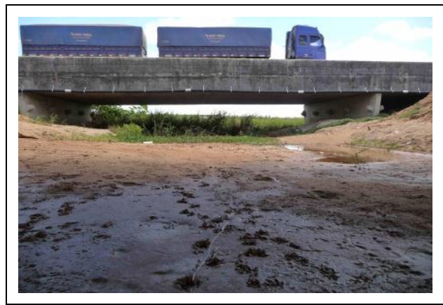
Figura 55. Pontilhão Várzea 1, BR 392/RS, com laterais secas para passagem de fauna. (Coord. Geogr. 52°19'28\"W / 31°49'04\"S, WGS84)
