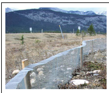
Figura 90. Cerca com malha fina, para anfíbios e répteis (CLEVINGER & HUIJSER 2011).
