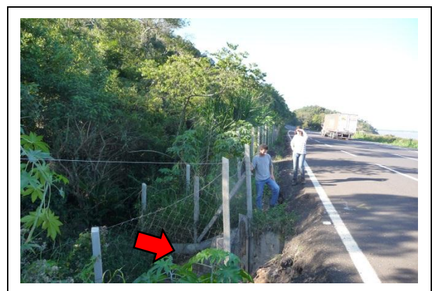
Figura 21. Entrada de passagem de fauna (seta) na BR 101/RS, com cerca direcionadora.
