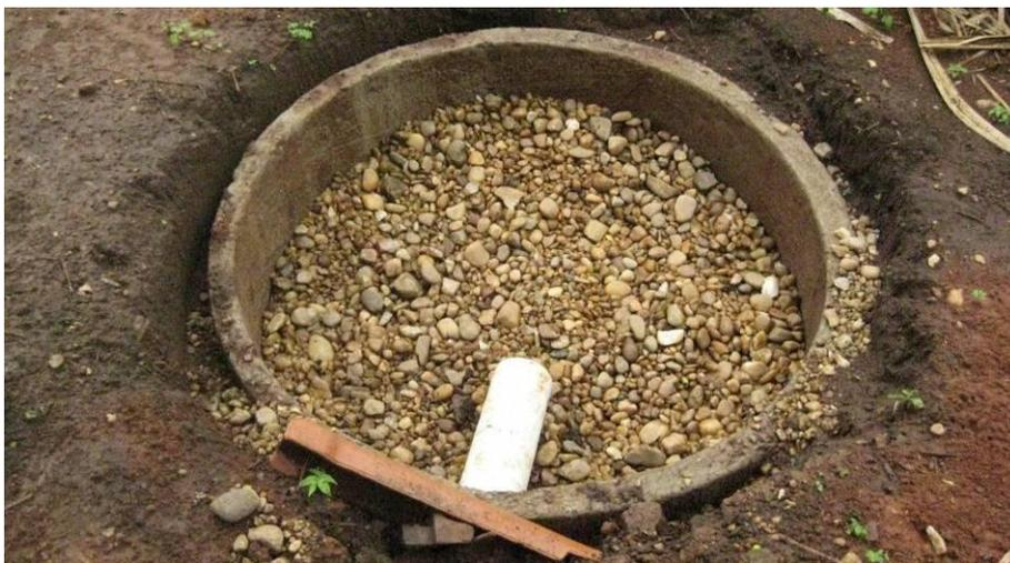
**Figura 2.2** - Detalhe do preenchimento com cascalho lavado.
