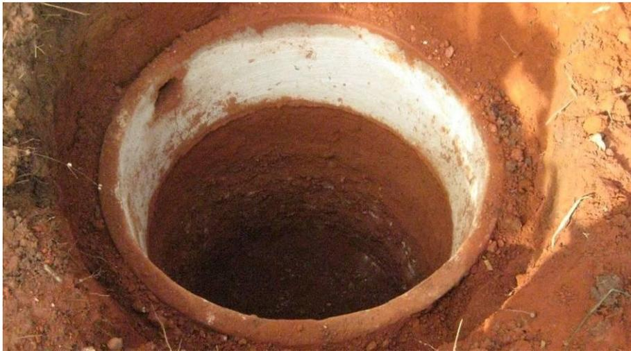
**Figura 2.1** - Detalhe construtivo da caixa de recarga, antes de seu preenchimento.
