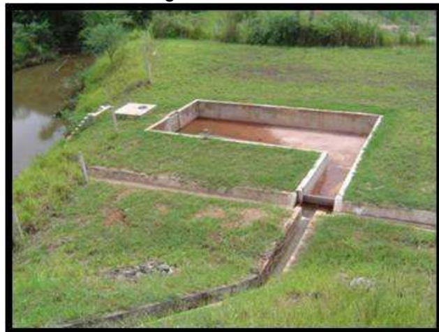
Foto B5 – Prolongamento da Rodovia dos Bandeirantes - SP 348 Concessionária Autoban. Fonte: Arquivo da Cetesb, emergências, 2010.
