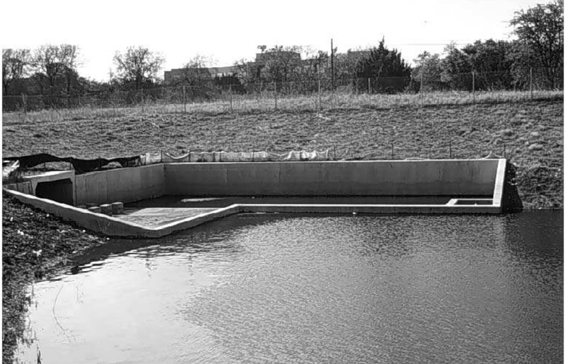
Foto 3 –Bacias de detenção alinhadas (Lined Detention Basins) com sifão. Fonte: City of Austin, Barrett (1999 apud MARLER, BARRET & MALINA, 2005).
