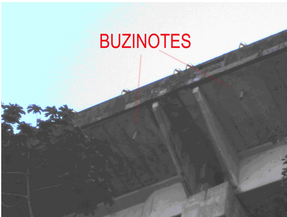
Foto 14: Pista ascendente da imigrantes. Uso de buznotes 22 . Descarga livre de poluentes sobre área protegida. Fonte: Autor.
