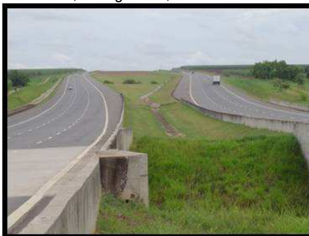
Foto B3 – Prolongamento da Rodovia dos Bandeirantes - SP 348 Concessionária Autoban. Fonte: Arquivo da Cetesb, emergências, 2010.
