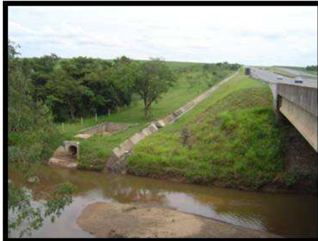
Foto B4 – Prolongamento da Rodovia dos Bandeirantes - SP 348 Concessionária Autoban. Fonte: Arquivo da Cetesb, emergências, 2010.
