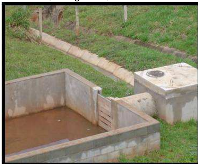
Foto B6 – Prolongamento da Rodovia dos Bandeirantes - SP 348 Concessionária Autoban. Fonte: Arquivo da Cetesb, emergências, 2010.
