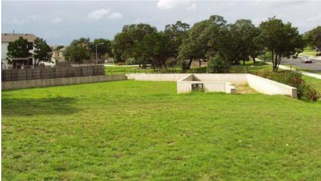
Foto A1 – Texas, EUA. Bacia de retenção de produtos perigosos na “503 Mesa Verde Court”.
