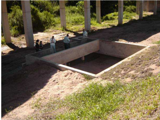
Foto B10 – Concessionária Colinas Fonte: Arquivo da Cetesb, emergências, 2010.
