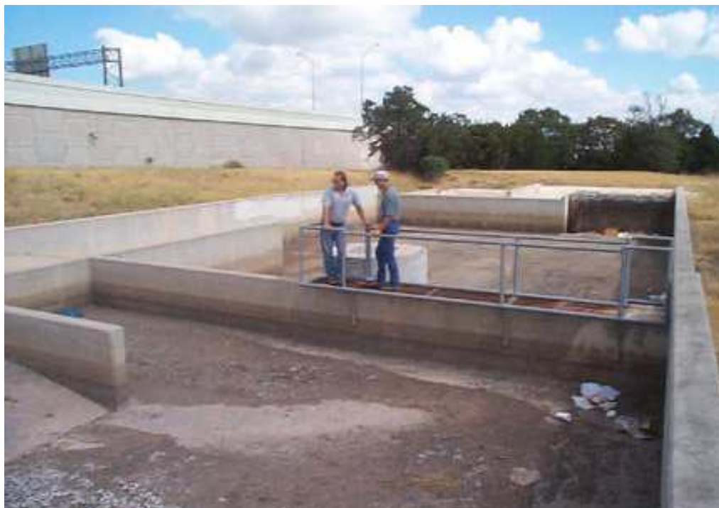
Foto A3 – Texas, EUA. Bacias na “ MoPac Best Buy ”. Fonte: Landphair, Mcfalls & Thompson, 2000; Filtro de areia.
