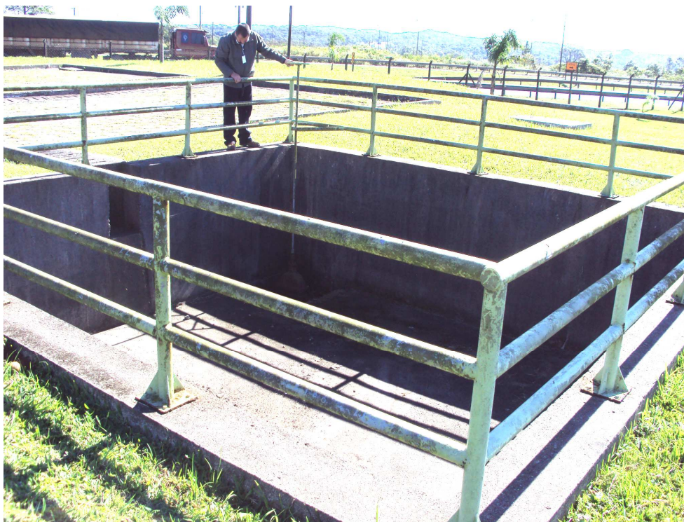
Foto 6 – Detalhe da caixa de contenção no pátio de estacionamento de caminhões na Rodovia Anchieta. Fonte: Elaborado pelo autor.
