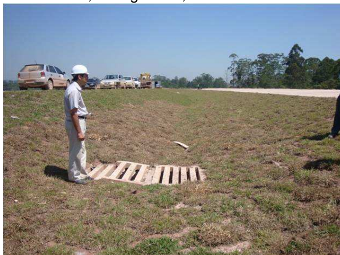
Foto B18 – Rodoanel Mario Covas – Trecho Sul. Captação de canteiro central. Dersa. Fonte: Arquivo da Cetesb, emergências, 2010.
