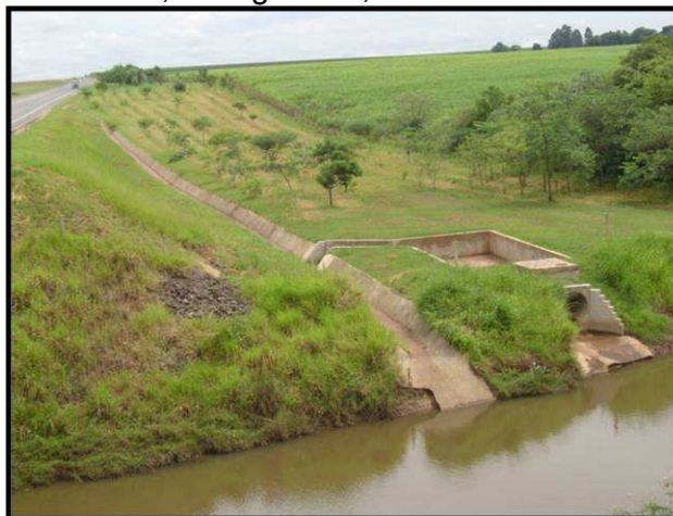
Foto B2 – Prolongamento da Rodovia dos Bandeirantes - SP 348 Concessionária Autoban. Fonte: Arquivo da Cetesb, emergências, 2010.
