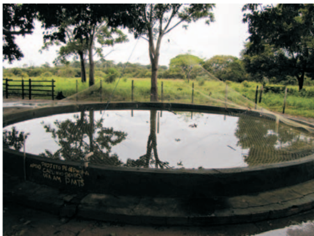
Figura 5 – Berçário de alvenaria com formato redondo e tela para proteção contra, principalmente, aves predadoras.
