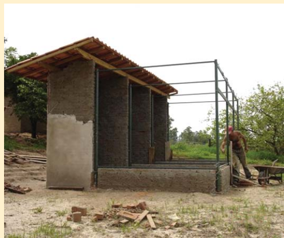
Construção dos viveiros de readaptação e soltura (detalhe do alçapão superior)
