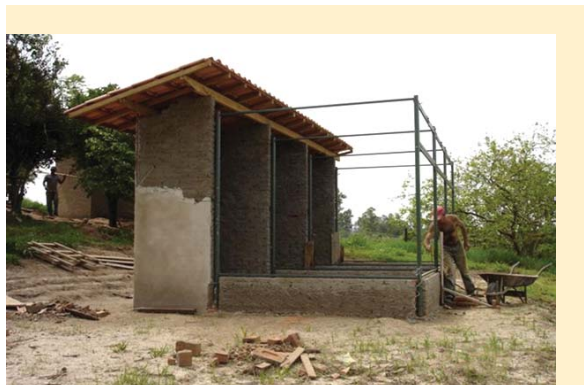
Construção dos viveiros de readaptação e soltura (detalhe do alçapão superior)
