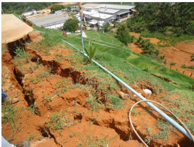
Foto 4: Risco de rompimento de barragem verificado em vistoria realizada pelo Ibama em 2014
