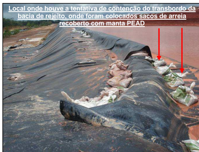
Figuras 16 e 17: Constatação do impacto ao meio ambiente causado pela transbordo da bacia de rejeito. Detalhe do Local de transbordo da bacia de rejeito, fato que foi negado pelos funcionários da ALUNORTE.
