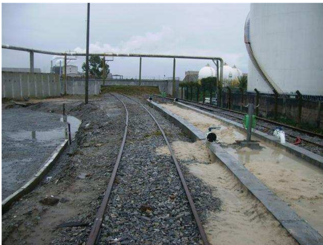
Figura 19: à esquerda, área em pavimentação. Ao fundo, à direita área em plano inferior aos trilhos por onde escorreu parte do produto que atingiu a Vila Becker.
