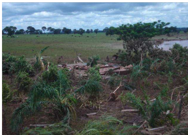
Figura 20. Casa, localizada nas margens na GO 178, derrubada pela força das águas. Foto tirada durante a vistoria realizada pelo IBAMA.
