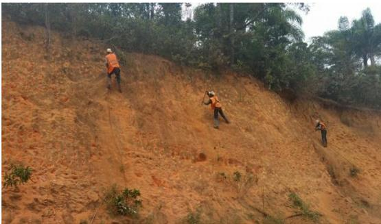
Foto 76 – Coveamento dos taludes
