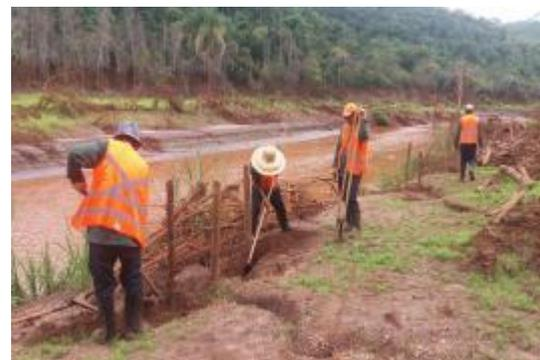
**Foto 37 – Construção de paliçadas - 08/03/2016**
