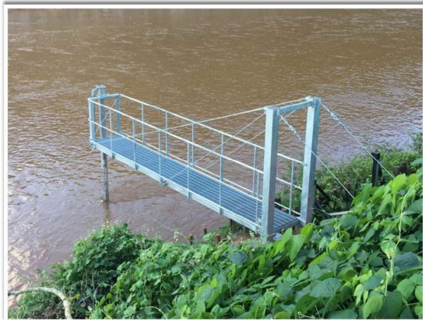
ESTAÇÃO TELEMÉTRICA RCA02
