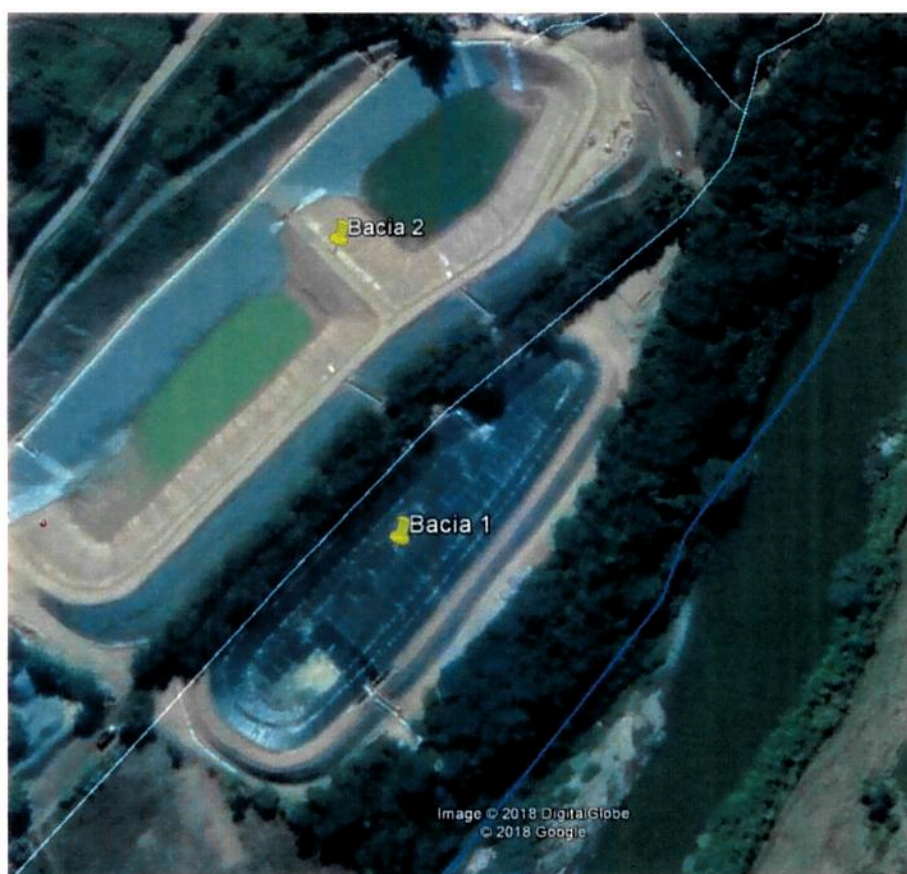
Figura 1 - Imagem da intervenção já realizada para implantação da Bacia 1
