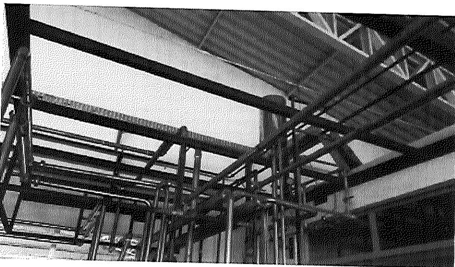
Troca da tubulação galvanizada de vapor por tubulação de inox
