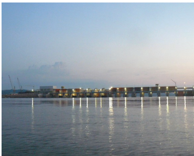
Figura 10 – Usina Hidrelétrica de Jirau, rio Madeira/RO (Foto: Daniely Félix-Silva).
