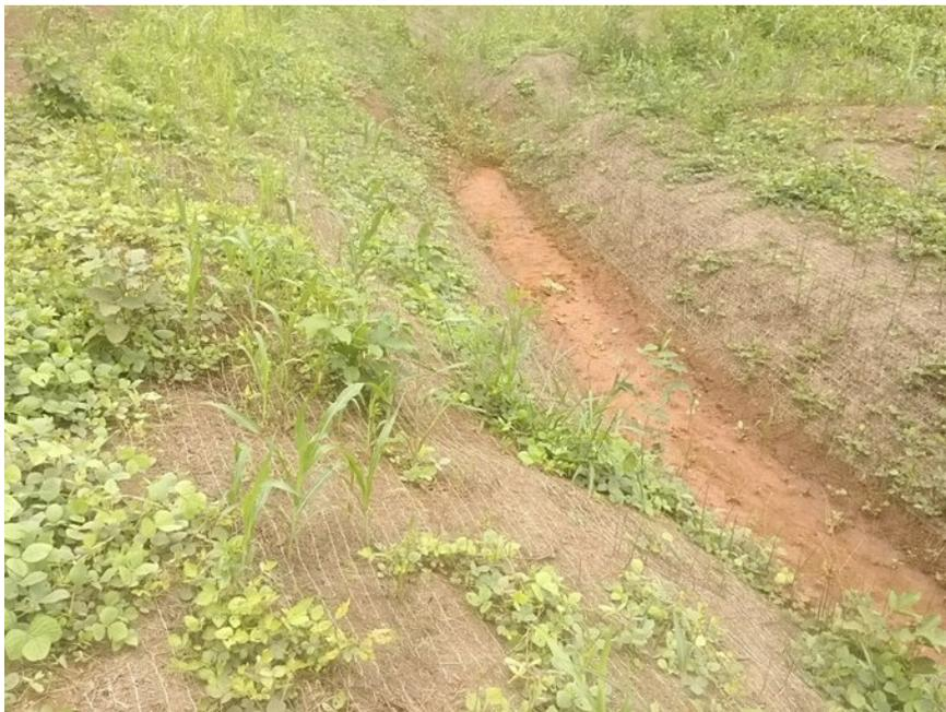
ITG 43 (1) – Durante a vistoria foi constatado o assoreamento das calhas de drenagem.
