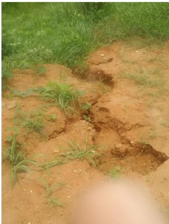
NTG 15 (4) - Durante a vistoria constatou-se que o desenvolvimento do mix foi insatisfatório com boa parte do solo exposto e com processos de ravinamento em andamento.
