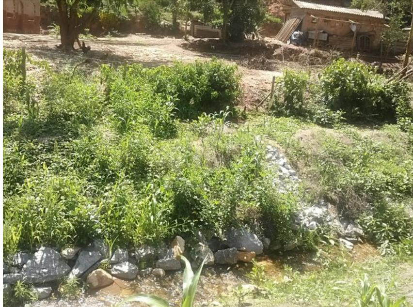
ITG 44 (3) – À montante do tributário observa-se a implantação do sistema de drenagem composto por enrocamentos e “bigodes” bem com a implantação de biomantas sobre a qual a vegetação encontra-se regenerando .
