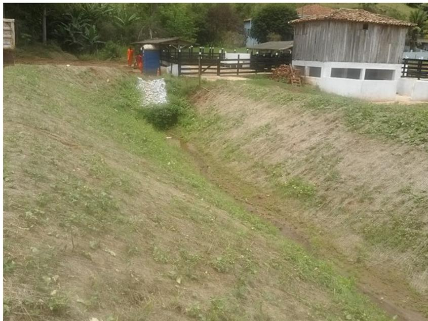
ITCE 01(2)- Aplicação de biomantas ao longo do tributário sobre a qual foi lançada mix de sementes. Na foto em destaque observa-se o enrocamento em pontos de drenagem.
