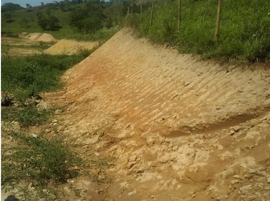
ITG 44 (1) - Durante a vistoria verificou-se a presença de áreas de empréstimo no qual há incorporação do solo provenientes dessas áreas ao rejeito.
