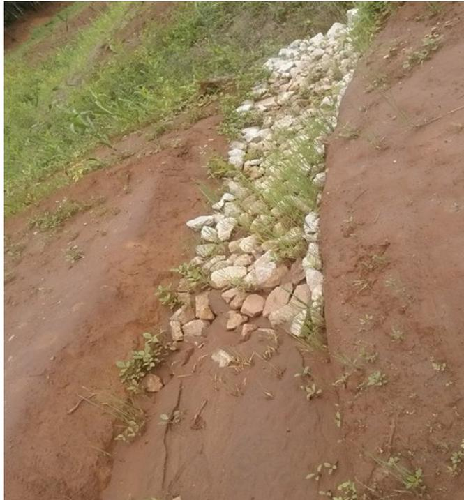
ITG 43 (3) –Durante a vistoria foi constatado o assoreamento dos enrocamentos presentes na área .
