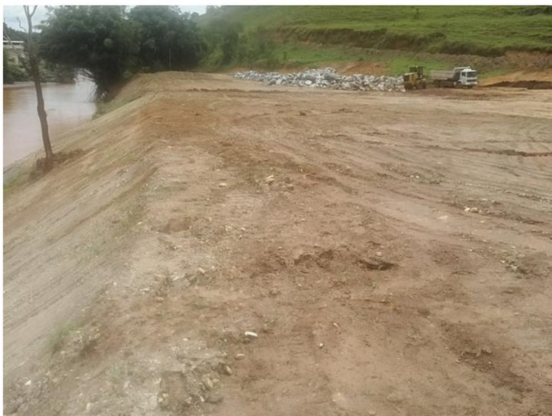
ITCE 01(4) - Área na margem direita do tributário onde o solo se encontra exposto servindo para depósito de materiais utilizados na contenção do rejeito.
