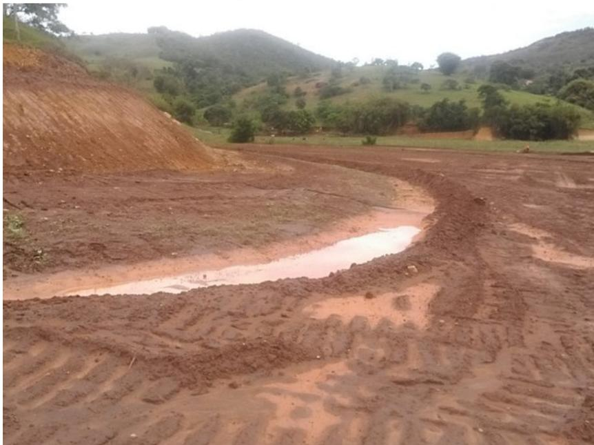
ITG 47 (1) – Planície de inundação localizada às margens do tributário com a presença de grande deposição de rejeito. Em destaque, o sistema de drenagem composto por canaletas as quais se encontravam assoreadas.
