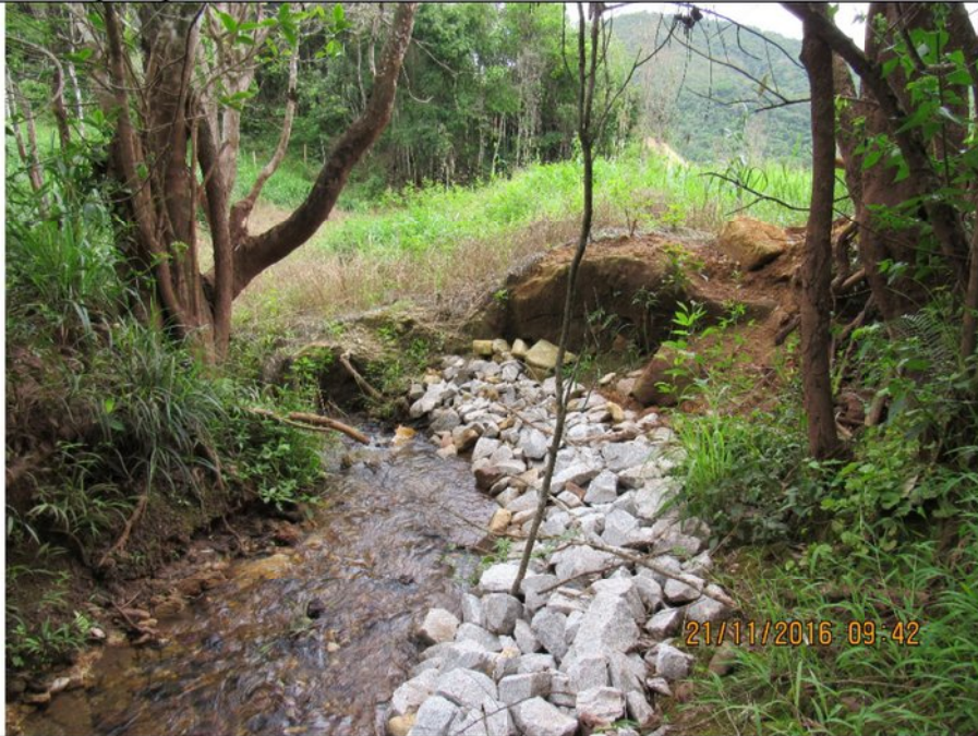
ITG 24 (4): Leito reconformado com aplicação de enrocamento no tributário ITG 24, no interior da propriedade do Sr. Haroldo.
