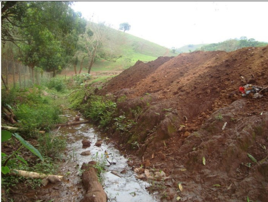
NTG 09 (2): Pilha de solo depositado em área de APP na margem esquerda do tributário NTG 09 resultante do processo de nivelamento do terreno na margem esquerda do corpo hídrico.
