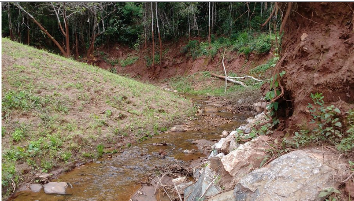
ITG 29 (1): À esquerda, barranco desprotegido no braço esquerdo do tributário ITG 29 com fragmento de vegetação nativa no entorno. À direita talude de ilha artificial formada pela reconformação do tributário com biomanata e mix de sementes implantados. Nota-se na biomanta pontos de estufamento e irregularidades.
