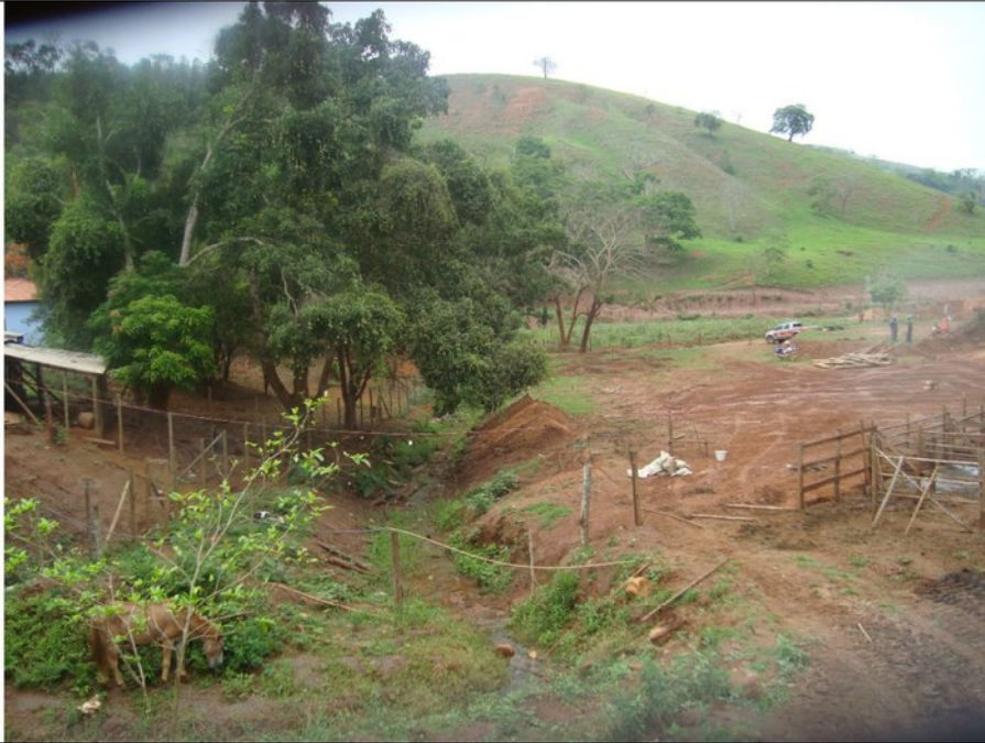
NTG 09 (1): Vista da área afetada do tributário NTG 09 acima da estrada principal de acesso. Na margem esquerda observa-se a área da propriedade rural cercada, onde houve nivelamento do rejeito e sobreposição de solo de barranco. À direita, nota-se a área onde houve nivelamento do terreno com corte do morro lateral para construção de curral.
