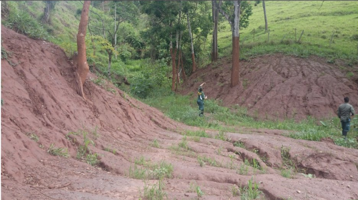
NTG 08 (2): Vista da foz do tributário NTG 08 com detalhe do acúmulo de rejeito tanto na margem direita quanto na margem esquerda. Nos dois taludes das duas margens do tributário intenso processo de ravinamento dado a ausência de ações de contenção aplicadas nessa área.
