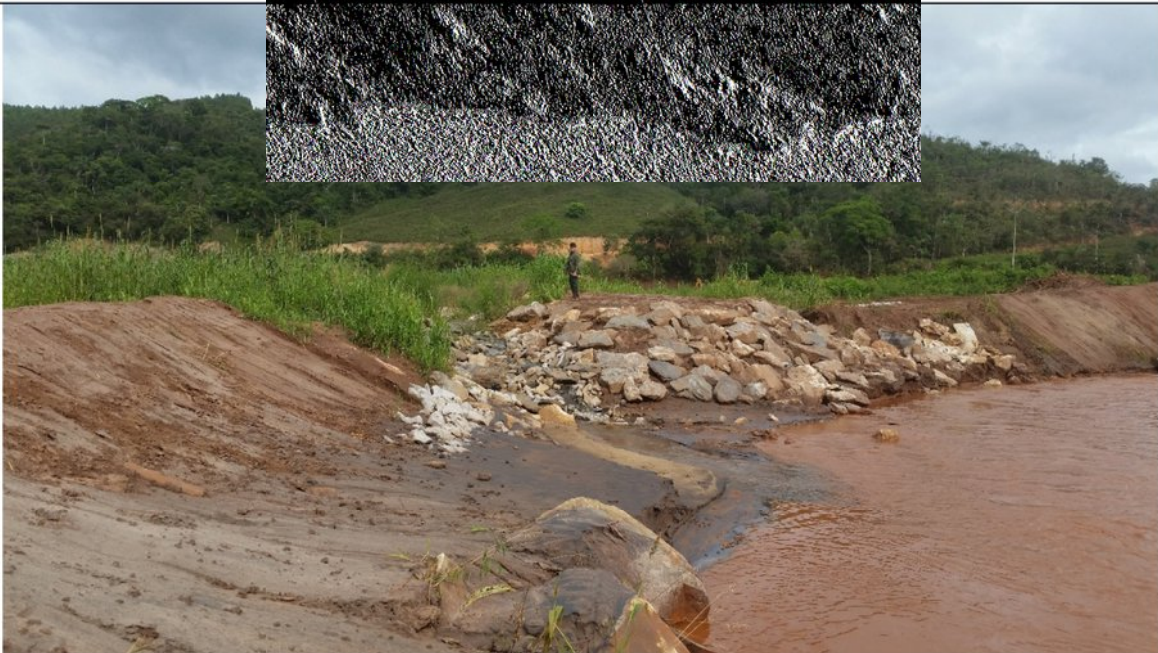
ITG 24 (1): Vista da foz do tributário ITG 24 com enrocamento nas duas margens, porém com taludes laterais à foz totalmente desprotegidos e susceptíveis à erosão fluvial. Detalhe de vegetação de mix de sementes bastante desenvolvida nos taludes marginais do tributário reconformado.
