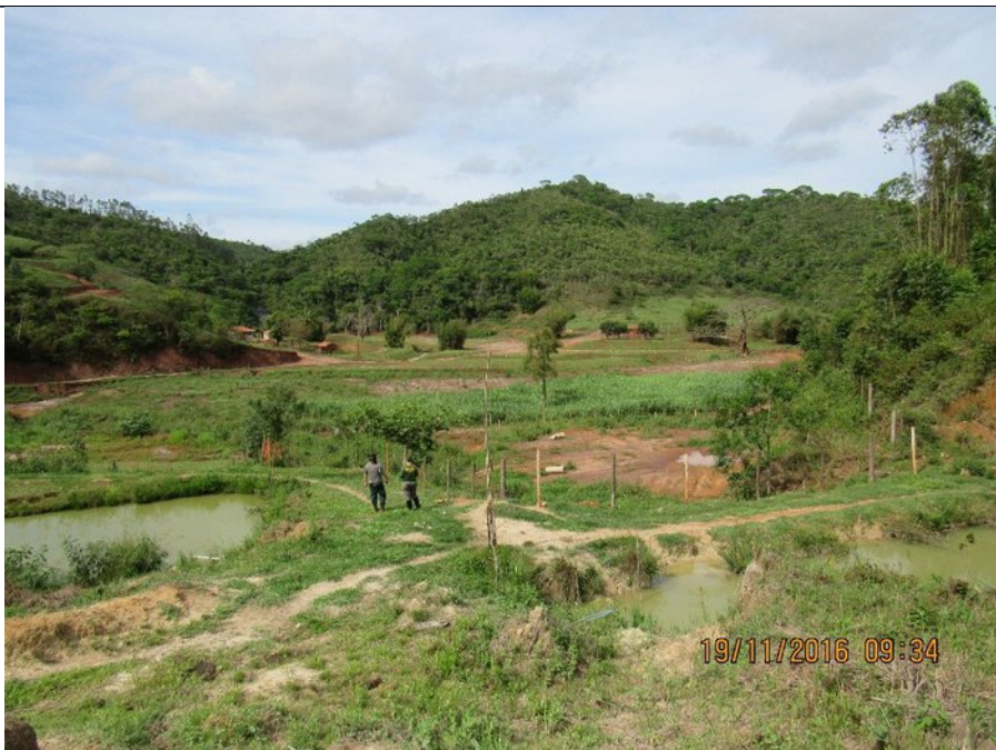
ITG30 (1): Vista das intervenções antrópicas no entorno do tributário ITG 30 , acima da estrada de acesso. À direita, barramento de terra no corpo do tributário e área de empréstimo de solo localizado na sua margem esquerda.
