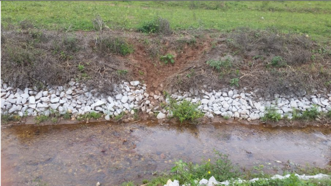
ITG22 (3): Detalhe de biomanta instalada nas margens do tributário ITG 22 que foi rompida por pastoreio de gado bovino e tráfego de equinos.
