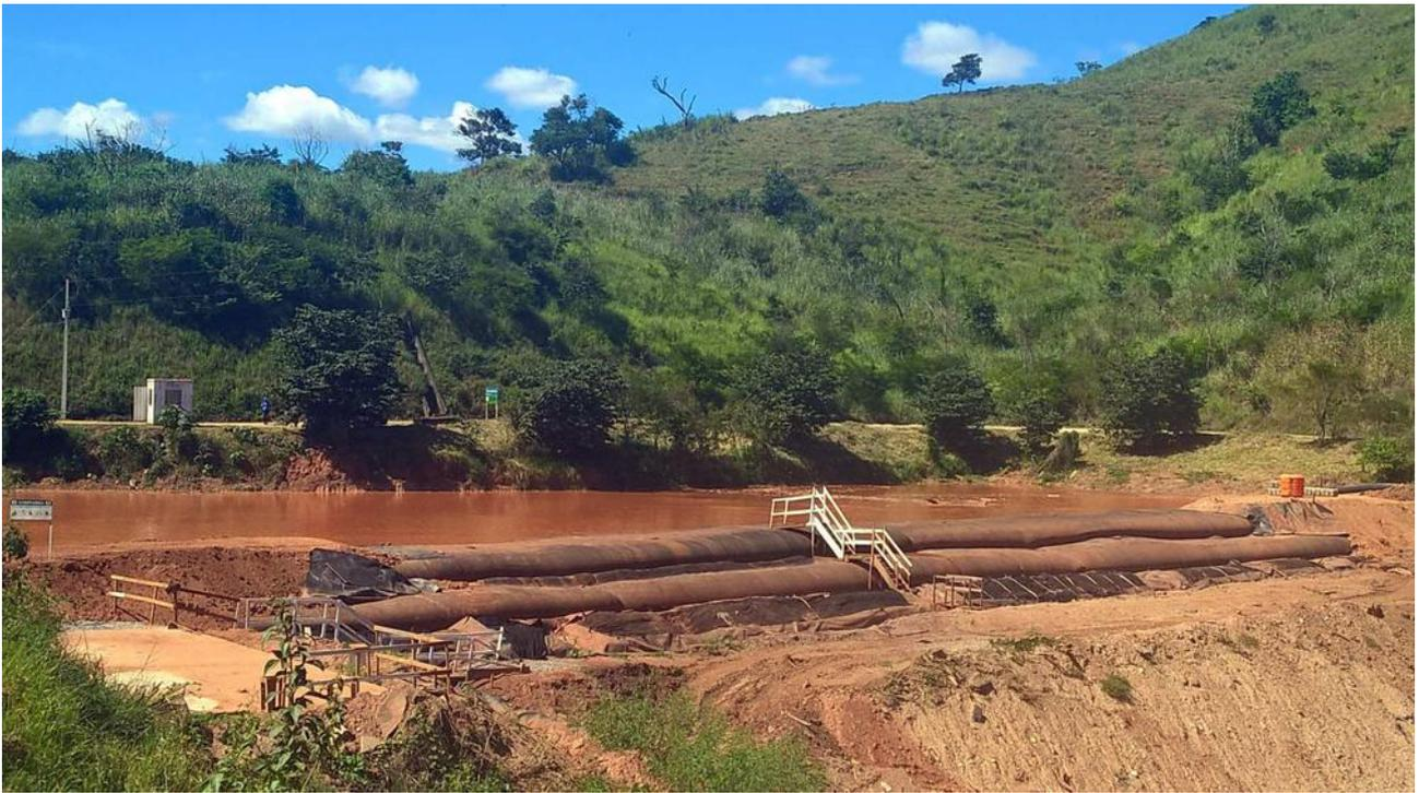
**Foto 50: Experimento piloto para verificar a eficiência do material a ser utilizado**
