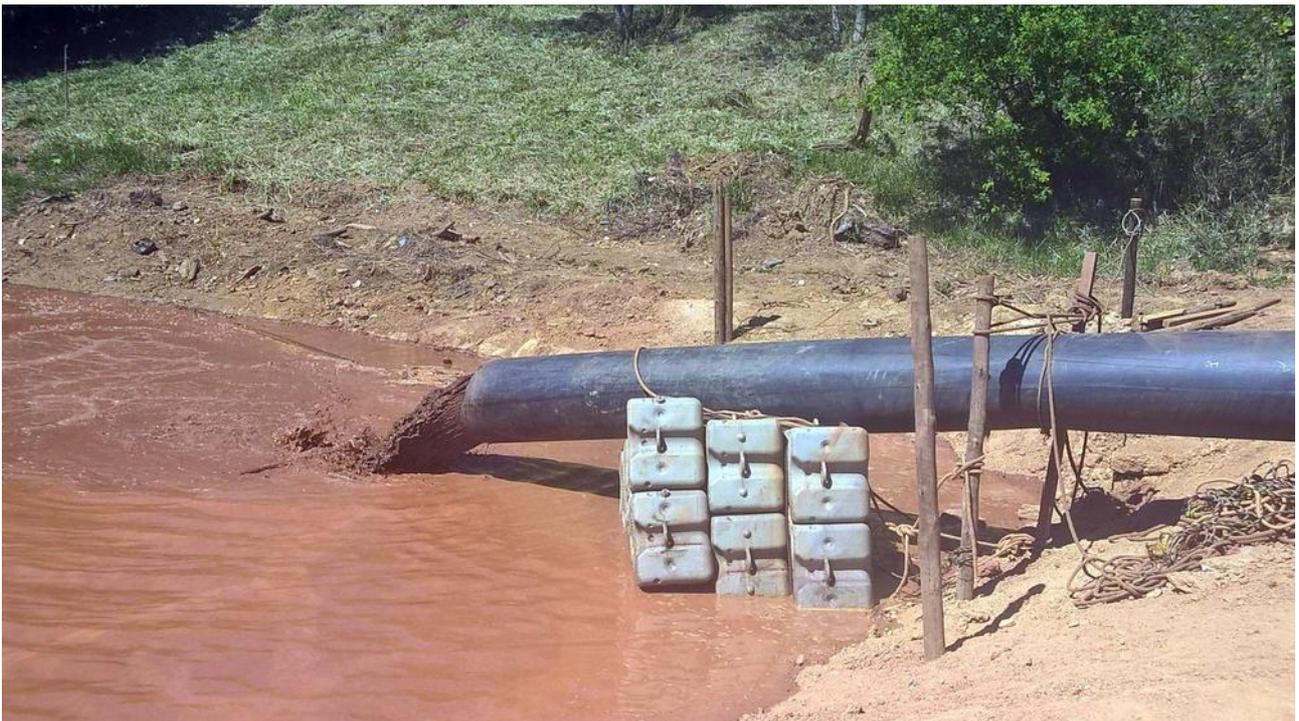
**Foto 51: Boca do tubo de descarte de rejeitos dragados para área de deposição do experimento**
