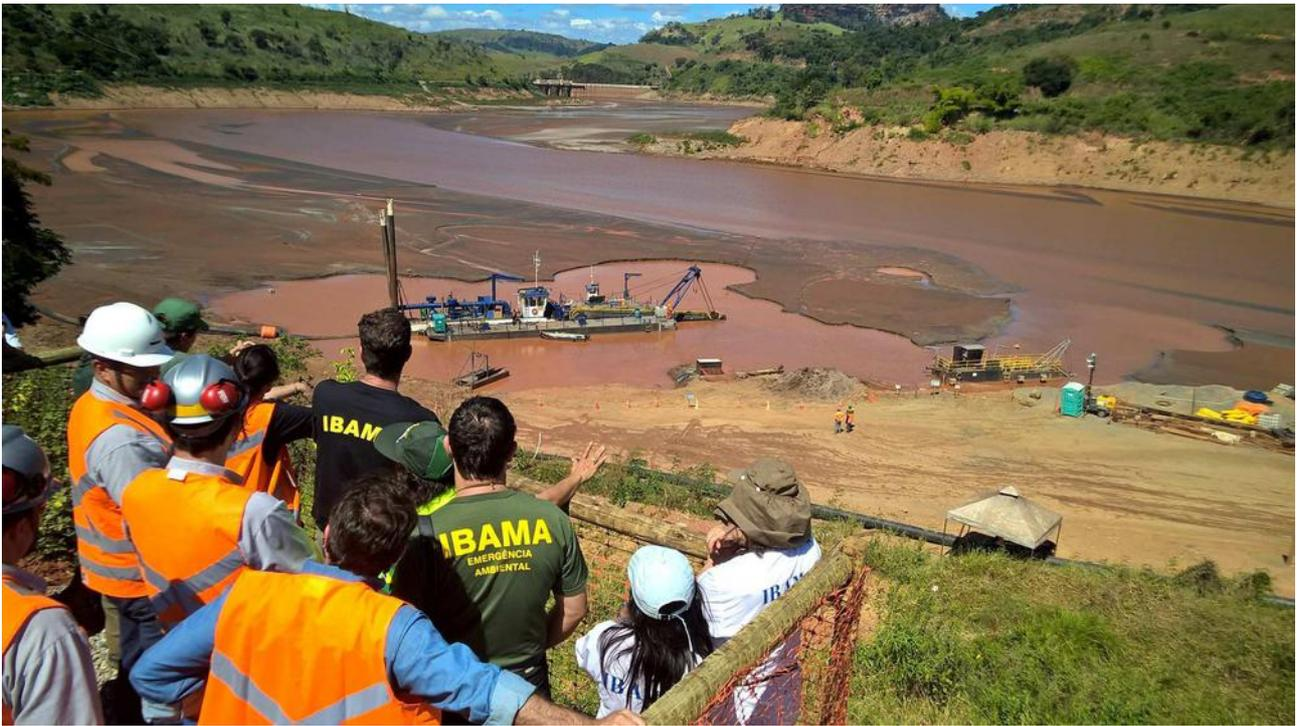
**Foto 48: Draga a ser utilizada para a remoção de parte dos rejeitos depositados em Candonga**
