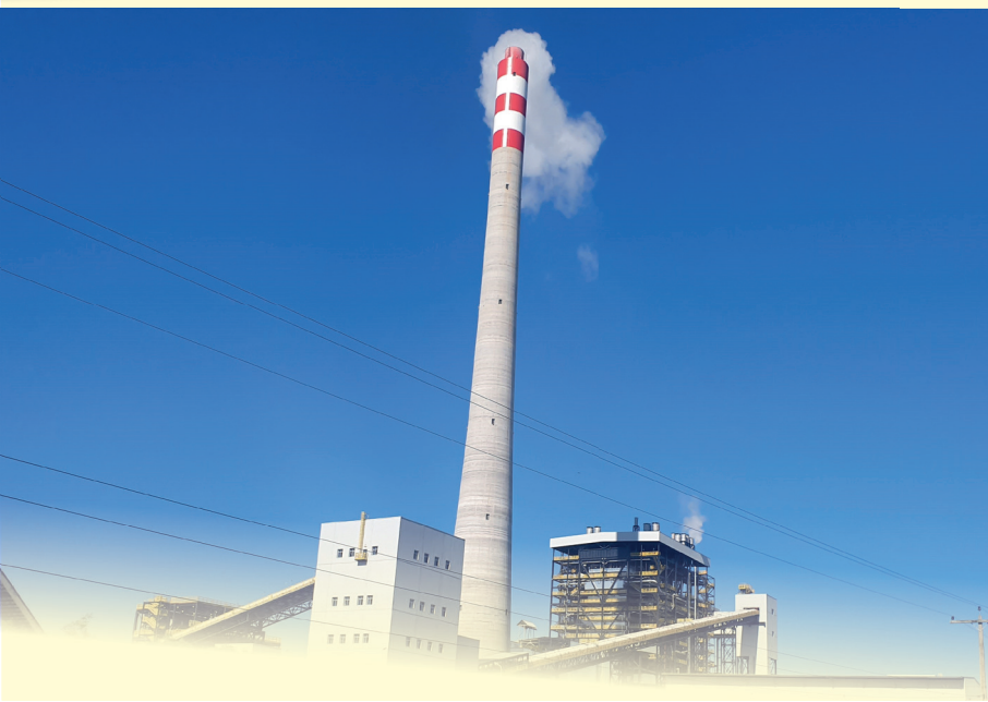
Vistoria realizada na Termelétrica Pampa Sul. Movida a carvão, a termelétrica praticamente não emite poluentes. A fumaça branca observada é o vapor de água produzido pela lavagem dos gases de combustão. Foto: Breno Bispo.
