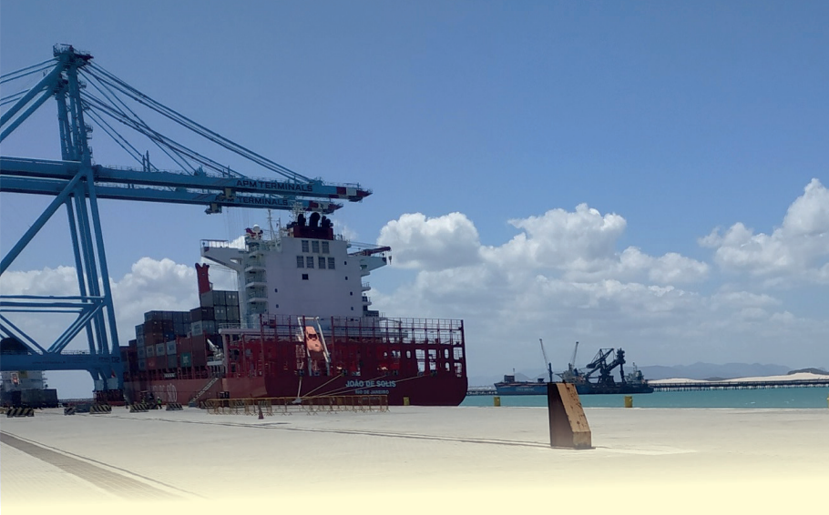
Grelha do sistema de drenagem do Berço 9 e superfície pavimentada do Berço 9 - Terminal Portuário de Pecém. Foto: Carlos Renato Schneider.
